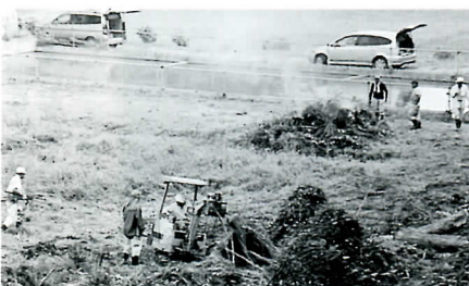
総代土砂流出復旧作業 17.8.26～
