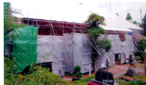
屋根シート覆
