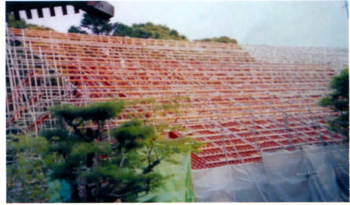
素屋根仮設工事
