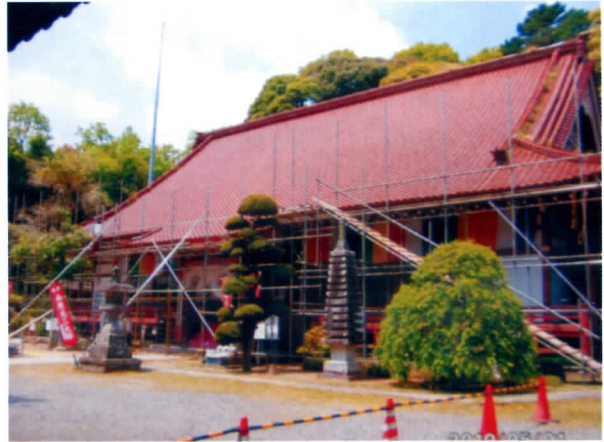
屋根修築工事着工 22・4・19
