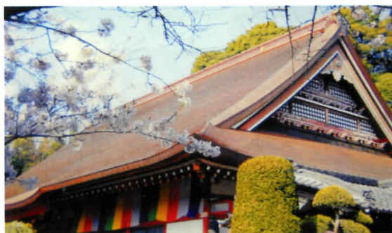
改修なった本堂屋根
