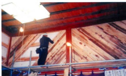
堂内全壁上に筋交づくり
