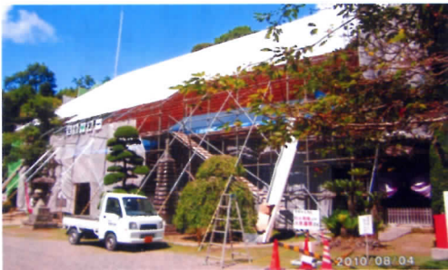
暑さの中瓦除去作業つく
